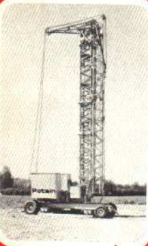
Dépliage de flèche dans 2 plans (Breveté)
